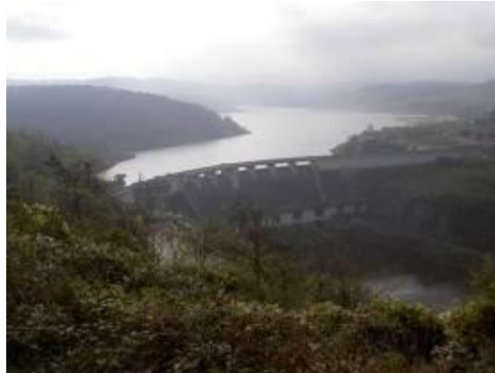
Figure 5 Barrage de Villerest
