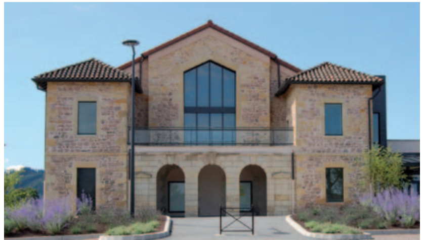
Réhabilitation à La Clayette (71), salle des fêtes Architecte A2DH, Montbrison
