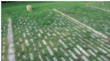
Stationnements pierres enherbées drainant.
