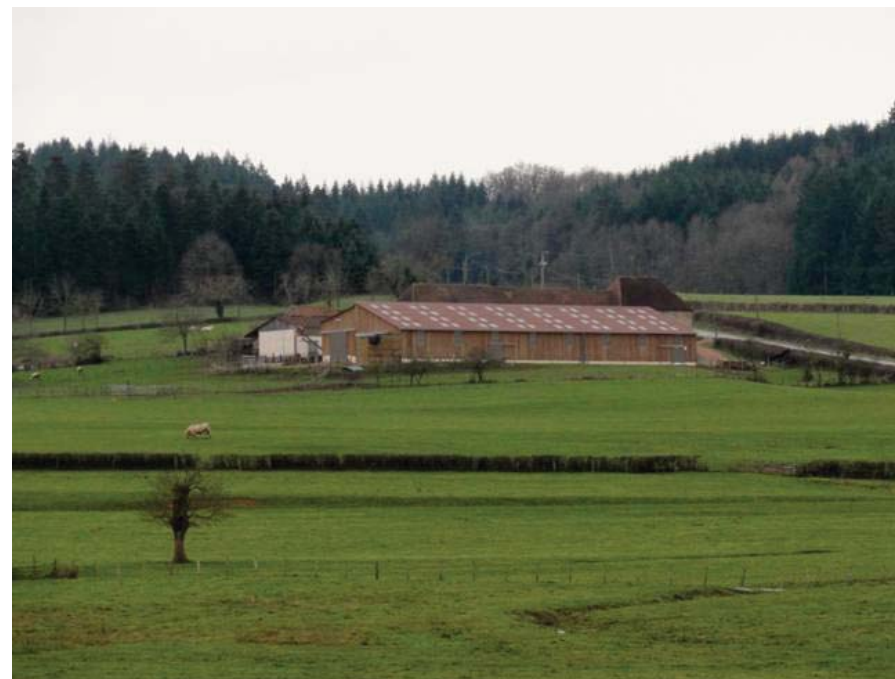
Beaubery, près RCEA, bâtiment agricole intégré dans la pente
