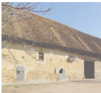
Ferme à Chamogé
