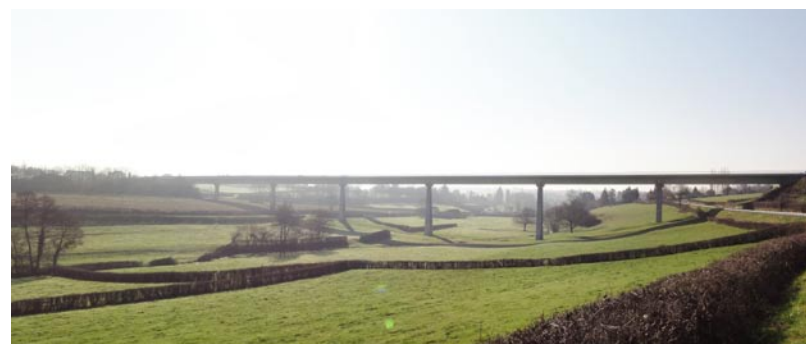
Viaduc de la RCEA à Charolles
