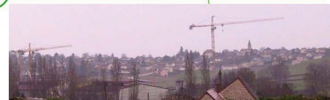
Grues de constructions sur le coteau de Baudemont
