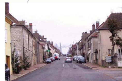
Alignement bâti sur la RD 983
