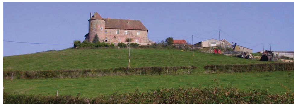
Château, ferme forte Montperroux - Grury
