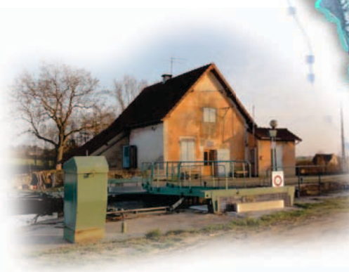
Maison d'éclusier vers Palinges, sur le Canal du Centre
