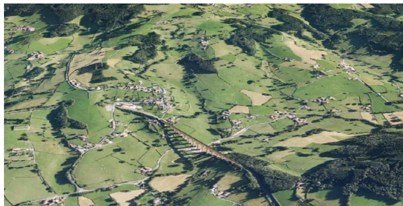
Vue aérienne 3D du Viaduc de Mussy-sous-Dun
