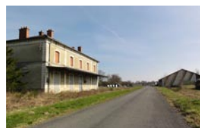
Ancienne gare et véloroute à Bourbon-Lancy
