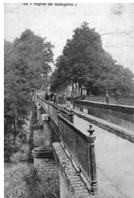
Carte postale ancienne du pont-canal de la Bourbince au début du XXe s.
