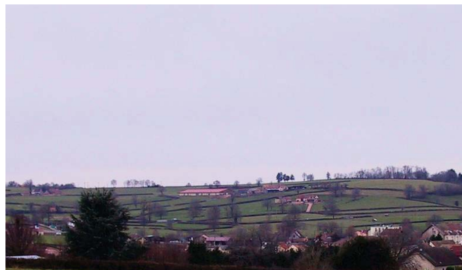
Au-dessus de St Bonnet-de-Joux, bâtiment agricole qui s'insère dans la pente
