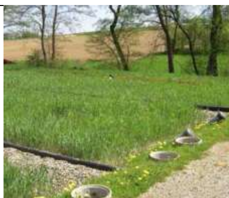
Station d'épuration en filtres à roseaux à écoulement vertical source : Agence de l'eau Rhin Meuse
