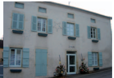
Bâtiments communaux réhabilités en logements locatifs aidés, Melay (71) Maitrise d'ouvrage communale
