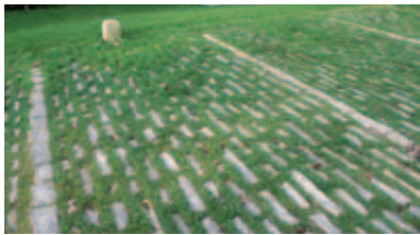
Stationnements pierres enherbées drainant.
